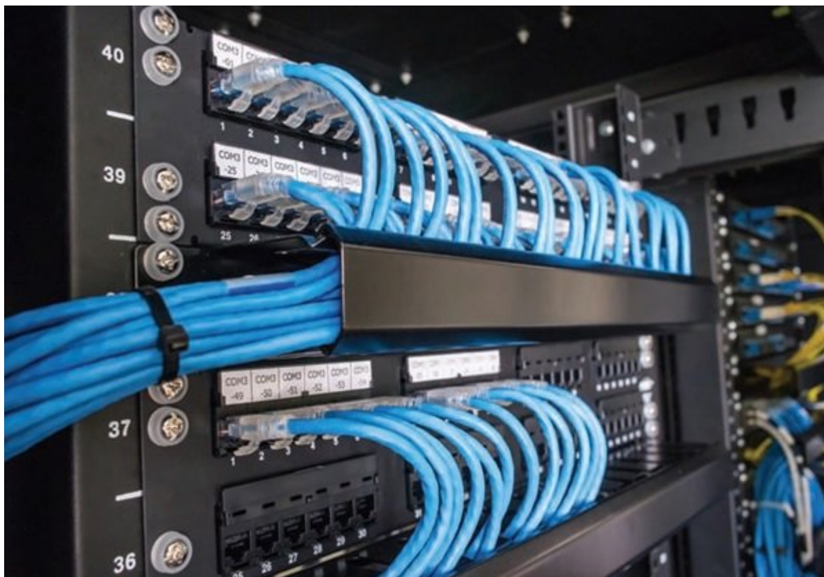
شکل زیر نمای روبرویی پچ پنل که هنوز پر نشده است را نشان می‌دهد.
